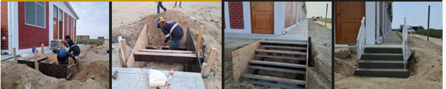
CONSTRUCCION DE ESCALERA DE CONCRETO DE INGRESO DE LABORATORIO AGROVISION
