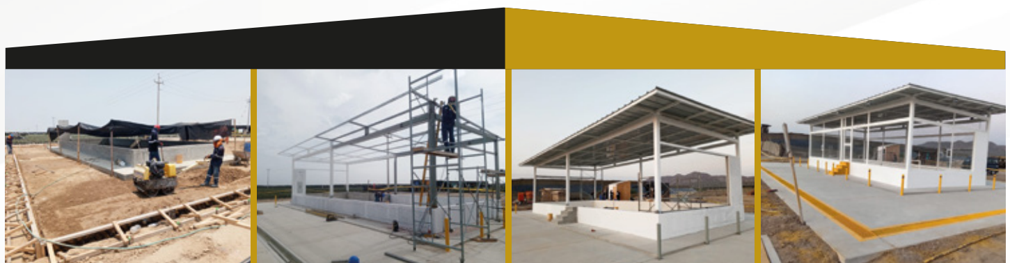
CONSTRUCCION DE SERVICIO DE BOMBEO DE COMBUSTIBLE A9-AGROVISION
