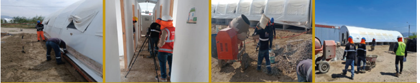
CONSTRUCCION DE PISOS PULIDOS PARA CARPAS DE ALOJAMIENTO - CAMPAMENTO ARENA VERDE
