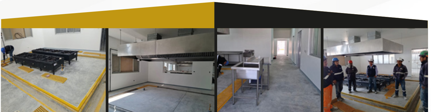
CONSTRUCCION DE REMODELACION DE COCINA C5-AGROVISION
