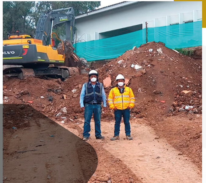
MOVIMIENTOS DE TIERRA
