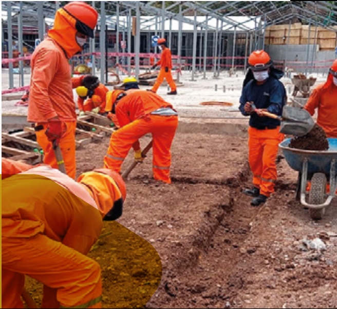
OBRAS DE SANEAMIENTO
